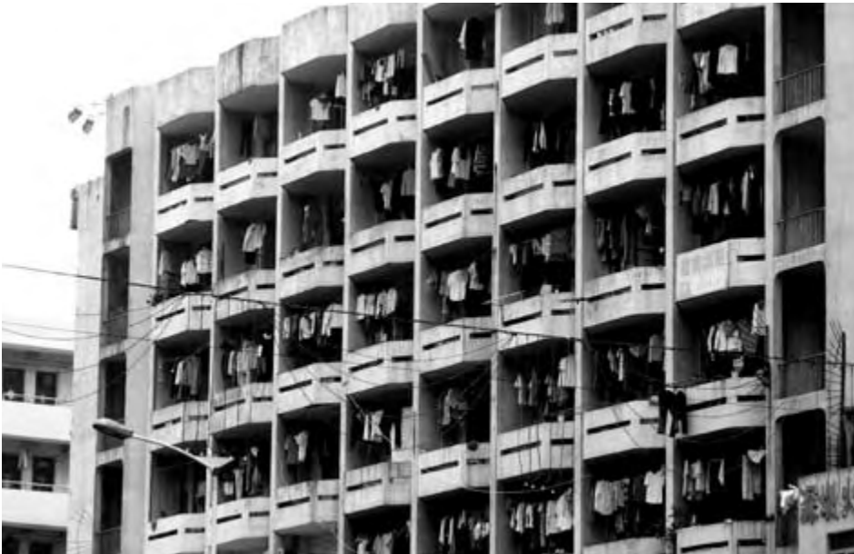
ArbeiterInnenwohnheim in China
